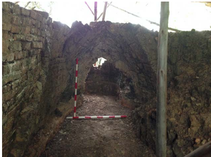
ภาพที่ 300 บริเวณปล่องระบายควันนั้นมีการก่ออิฐขึ้นมาเป็นลักษณะหน้าจั่ว
