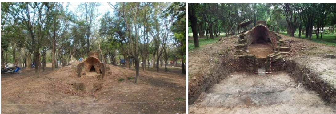
ภาพที่ 307-308 เตาหมายเลข สท.7 สภาพก่อนและหลังการขุดแต่ง
