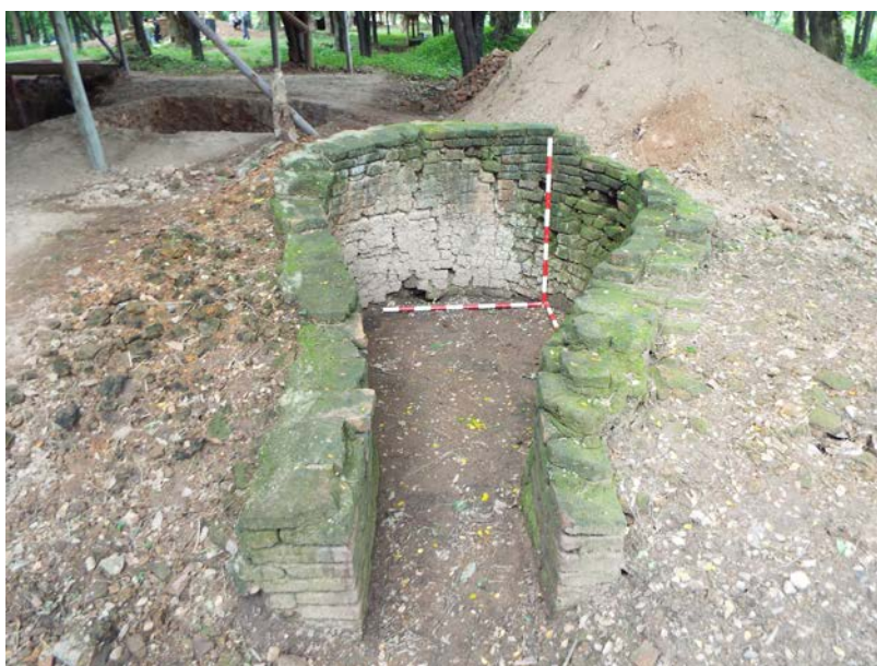
ภาพที่ 329 สภาพหลังจากการขุดแต่ง เตาหมายเลข สท.10 มุมมองจากด้านทิศตะวันออก
